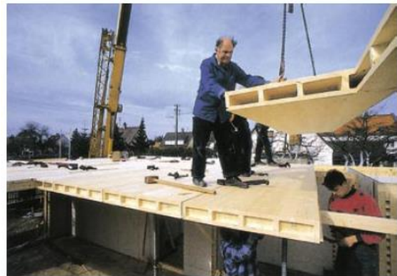
Obr. 2.52 Strop z lepených dutých tvaroviek [27]
