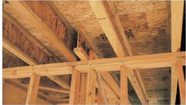
Obr. 2.51 Stropní konstrukce s I-profilu [5]
